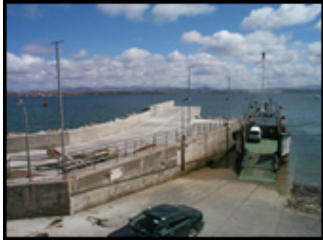
Phase 1 : New Breakwater
